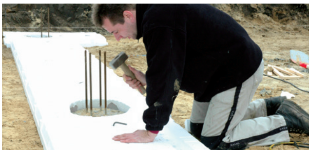
3 Met bodemplaten verbindingen maken tussen de hoeken.
