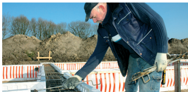
6 Bovenbeugels aanbrengen, ca. 600 mm h.o.h.
